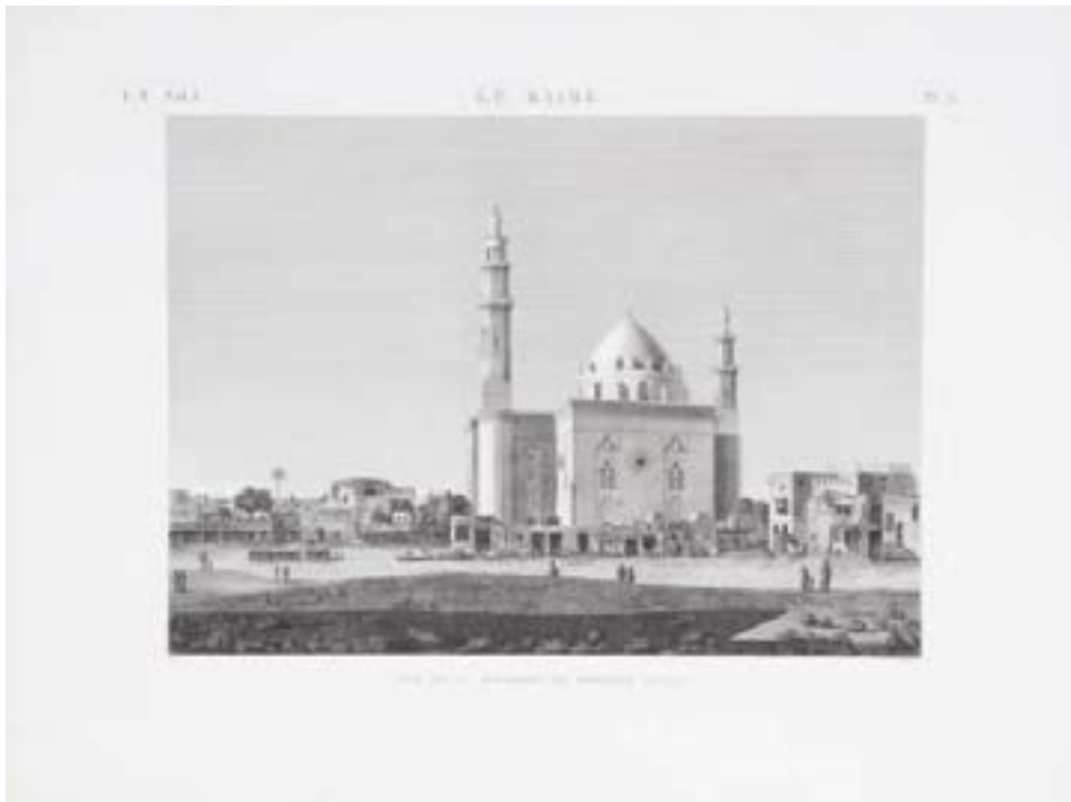
Le Kaire. Vue de la mosquée de Sultân Hasan. Drawing: Conté. Engraving: Berthault. Plates. Modern Age. Volume I. Plate 32.
